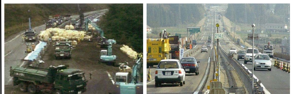
被災区間が4車線構造であったことの効果 (復旧ヤード確保) (通行帯確保)
